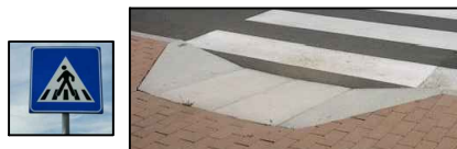
FOTO ESPLICATIVA INTERVENTO N.1
