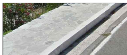
FOTO ESPLICATIVA INTERVENTO N.3
