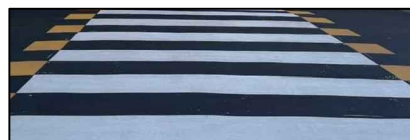
FOTO ESPLICATIVA INTERVENTO N.2
