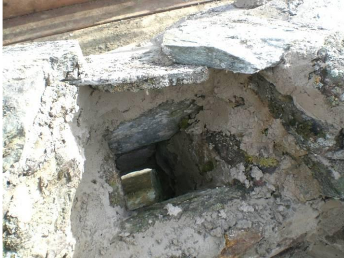
FIG. 07 – Scarico acque meteoriche
