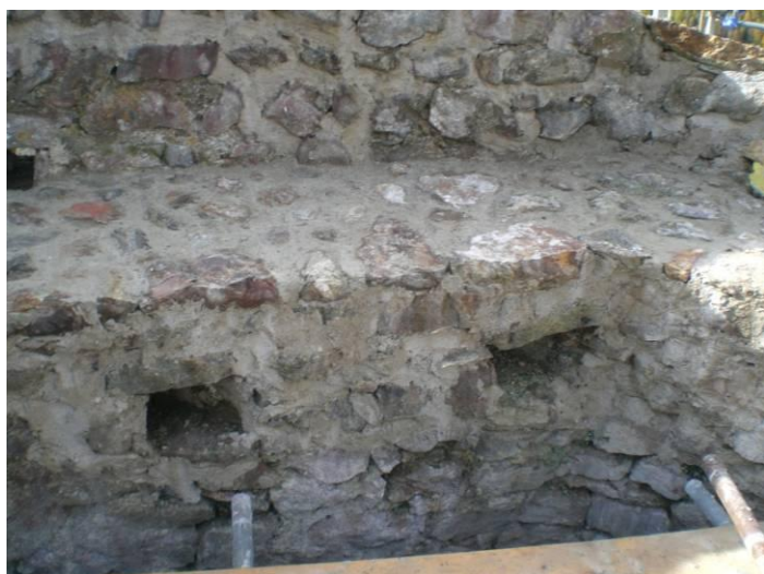
FIG. 06 – Fori alloggiamento travi
