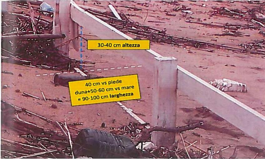
CATASTA DI LEGNAME: Catasta di legname a protezione dell'antiduna delimitata con pali infissi. Fissaggio con corda di canapa
