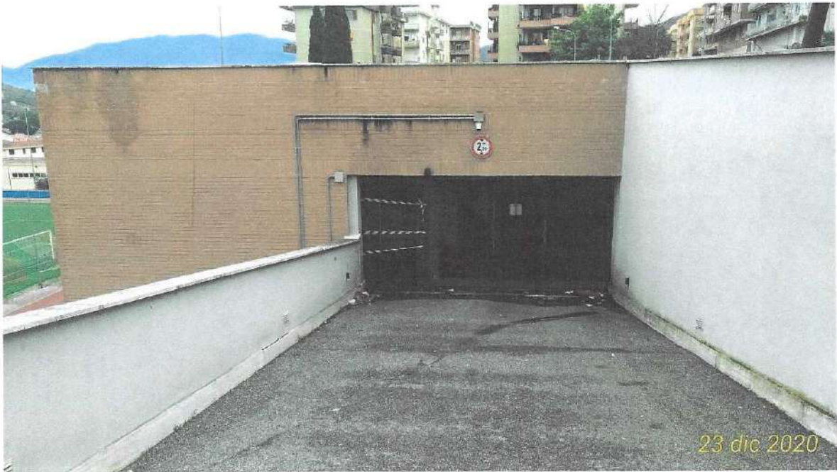
Vista ingresso piano primo sottostrada
