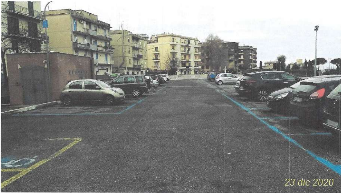
Vista lastrico piano terra
