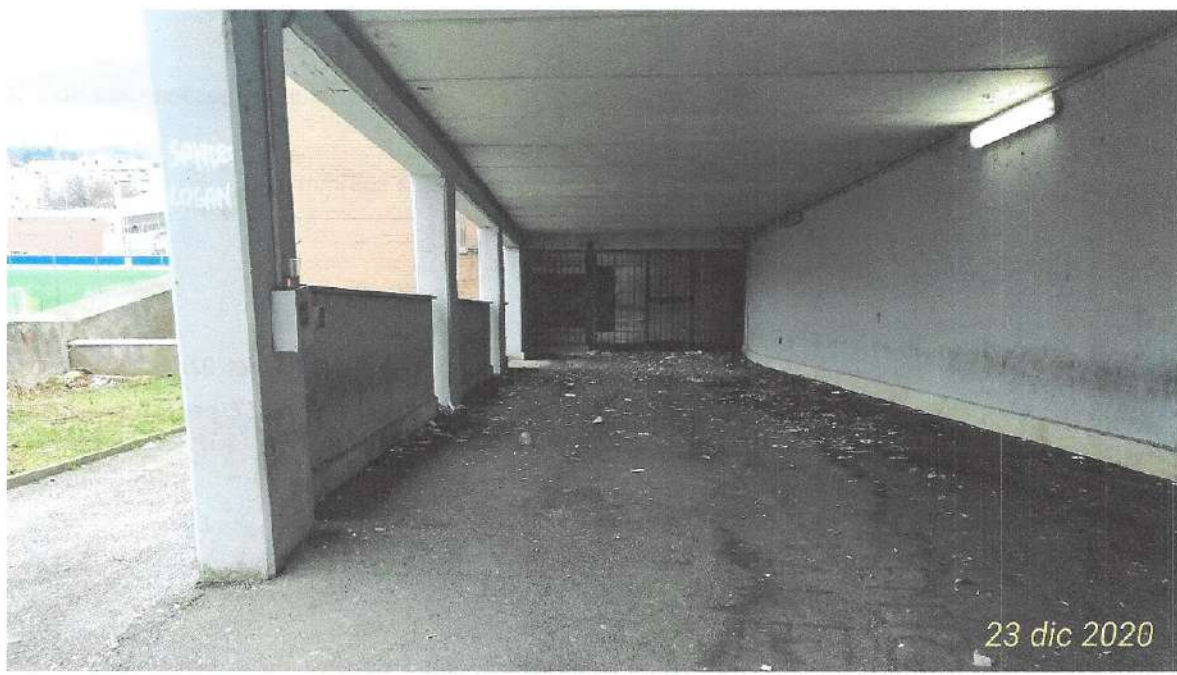
Vista ingresso piano secondo sottostrada
