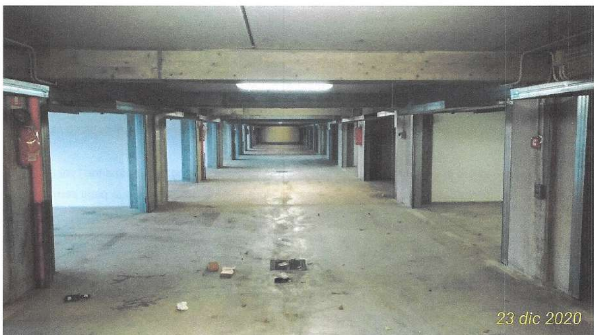
Vista piano secondo sottostrada
