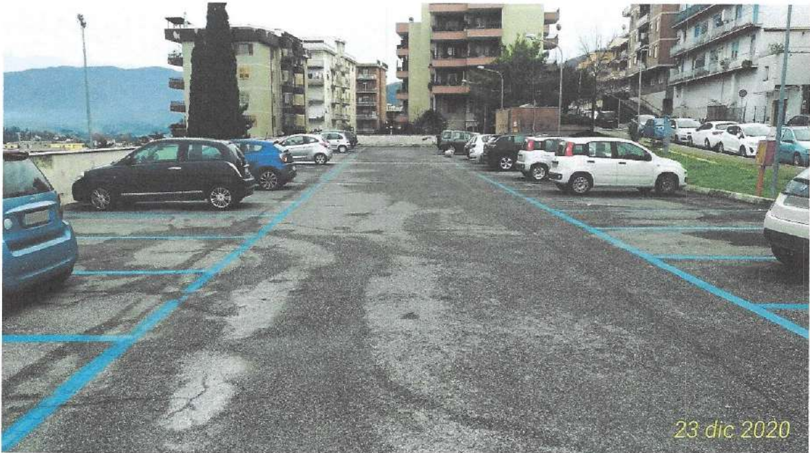
Vista lastrico piano terra
